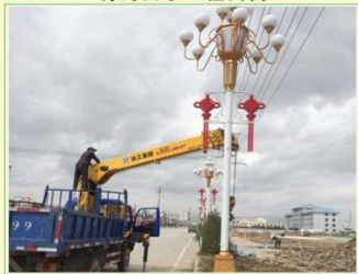
青海西宁工程实例
